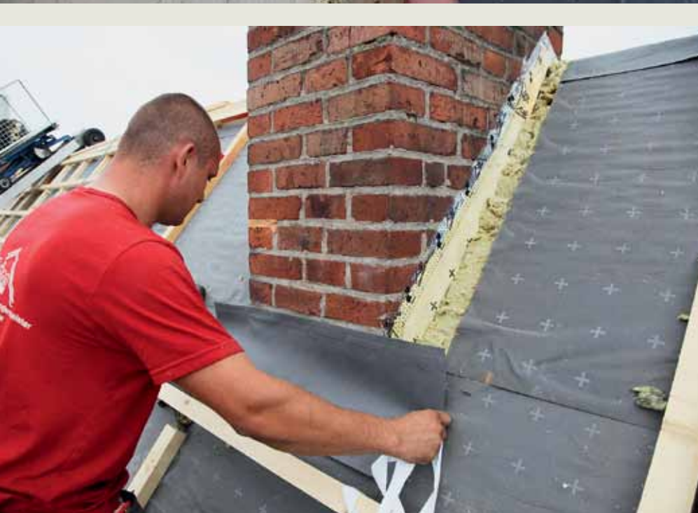
Die Anschlüsse an den Kamin werden mit dem Abdeckband angeschlossen. Die Ausführung der Dämmung am Kamin erfolgte aus brandschutztechnischen Gründen mit Mineralfaser.
